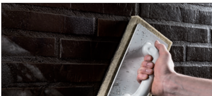
Mithilfe eines Putzbretts mit Schwamm- oder Schaumstoffauflage wird der überschüssige Mörtel diagonal abgewaschen.
