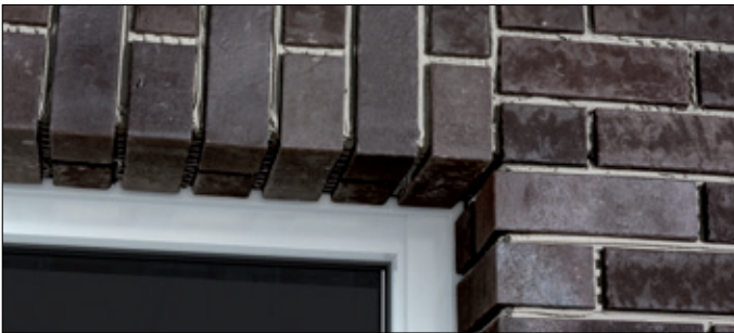
Ein perfekt mit Winkeln nachgebildeter Fenstersturz.
